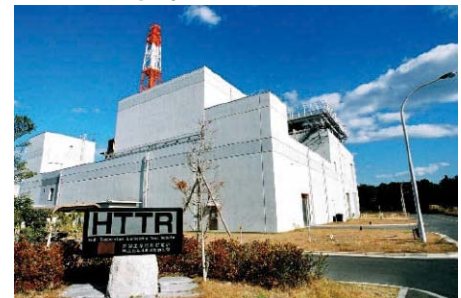
▲HTTR(高温工学試験研究炉)
